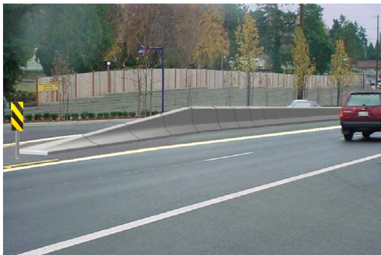
شکل ۲ - صفر نمودن سر آزاد حفاظ بتنی و یا مهار آن در ترانشه کناری در محل های با سرعت کم. در سرعت های بالا حسب شرایط ، نیاز به بکارگیری ضربه گیر مناسب در مقابل حفاظ بتنی می باشد.
