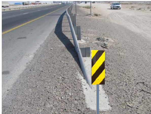
شکل ۱ - دور نمودن سر حفاظ و مهار آن در زمین یا ترانشه کناری
