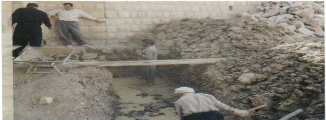
احداث پی کمکی و تزریق بتن به منظور تقویت پی و جلوگیری از نشست و رانش کوله
