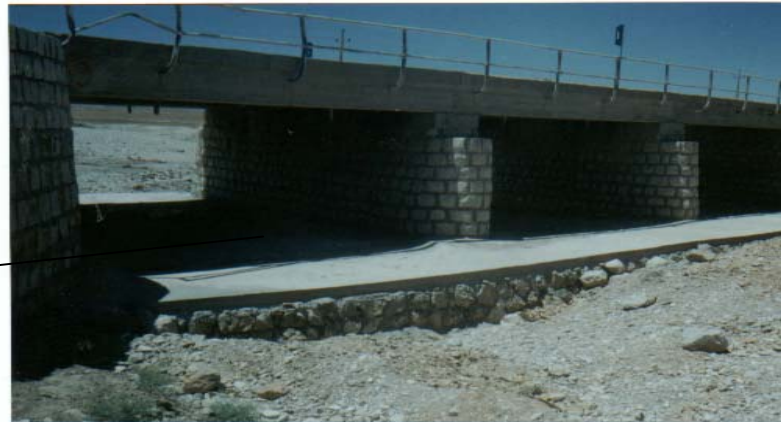
نمونه هایی از اجرای تعمیرات کف پل ها (رادیه)
