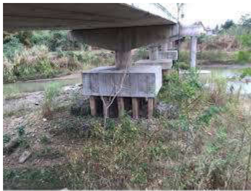
تصویر ۶- نمایان شدن فونداسیون و شمعهها
